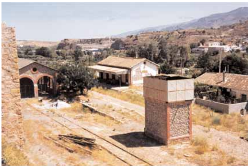
Instalaciones de la estación de Serón. Foto: Fundación de los Ferrocarriles Españoles
