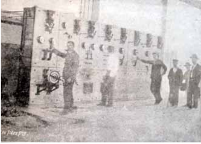
Cuadros eléctricos y motores a gas pobre existentes en la Central de Los Tranvías. Agosto de 1904. Foto Páez. Colección Felipe Nieto
