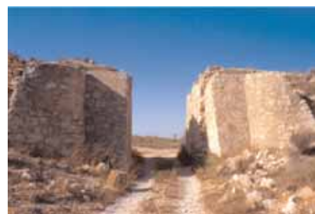
Puente dismantelado del ferrocarril. Foto ASAFAL
