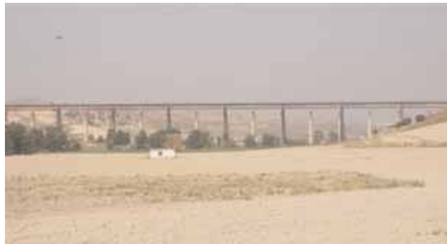
El Hacho visto desde la carretera de la estación. Detrás, el nuevo Hacho de hormigón
