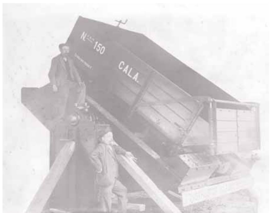
Basculador de vagones del embarcadero de Cala. Al pie posa Mariano de Corral, cuya empresa de Bilbao fue que la diseñó el sistema de descarga. Museo Vasco del Ferrocarril.
