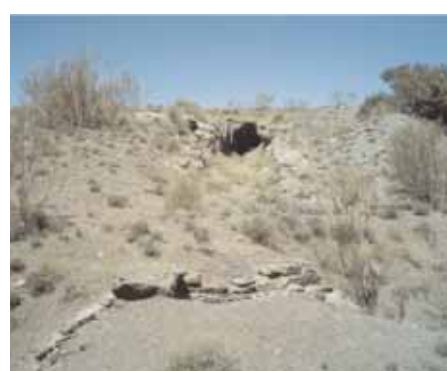
Salida del túnel y trinchera. Foto Carlos Peña Aguilera
