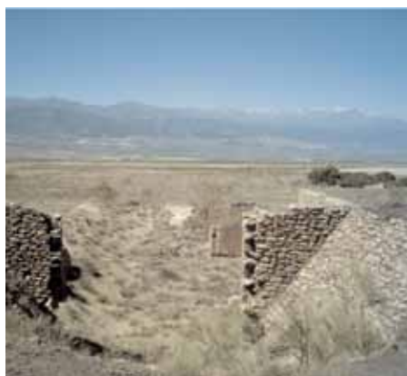
Tolva de carga y origen del cable. Foto Carlos Peña Aguilera
