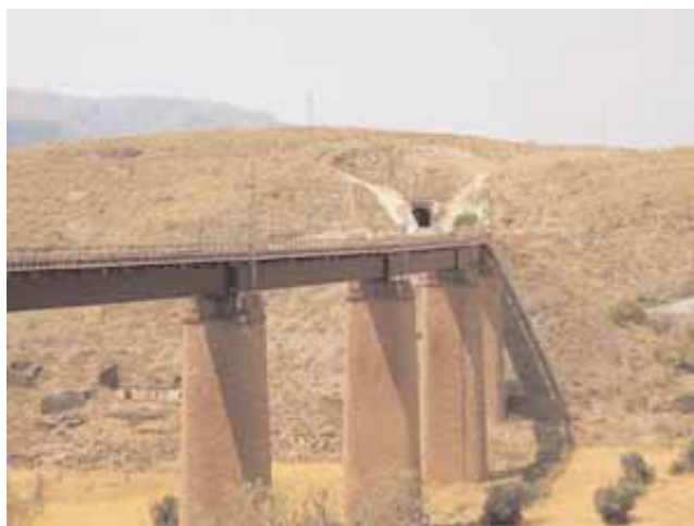
Escúllar: En curva y túnel
