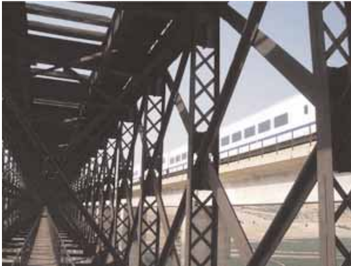
En la pasarela de servicio del Hacho metálico.
