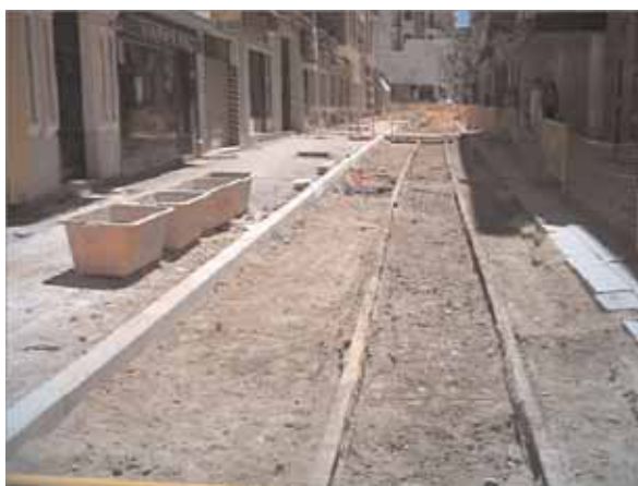
Railes Phoenix originales de la línea de La Tortilla, tal y como se encontraban cuando fueron descubiertos gracias a las obras de la calle Canalejas. Julio 2005. Foto Andrés Padilla
